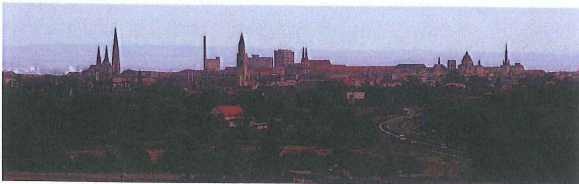
Dálkový pohled od Křelova se zvýrazněnou současnou siluetou narušenou komínem teplárny, objekty sil a RCO
