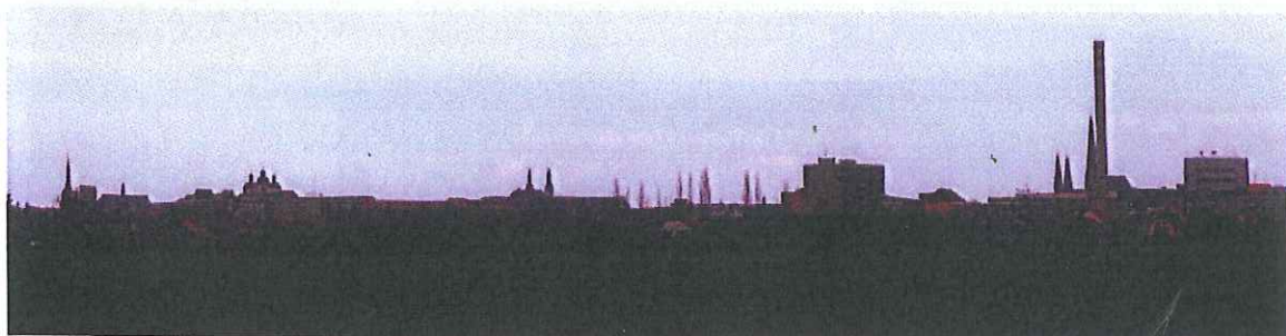
Pohled přibližně z téhož úhlu (ulice Keplerova/Šlechtitelů) – se zvýrazněnou siluetou narušenou převýšeným panelovým domem (25m) při ulici Přichystalova, a zejména komínem teplárny
