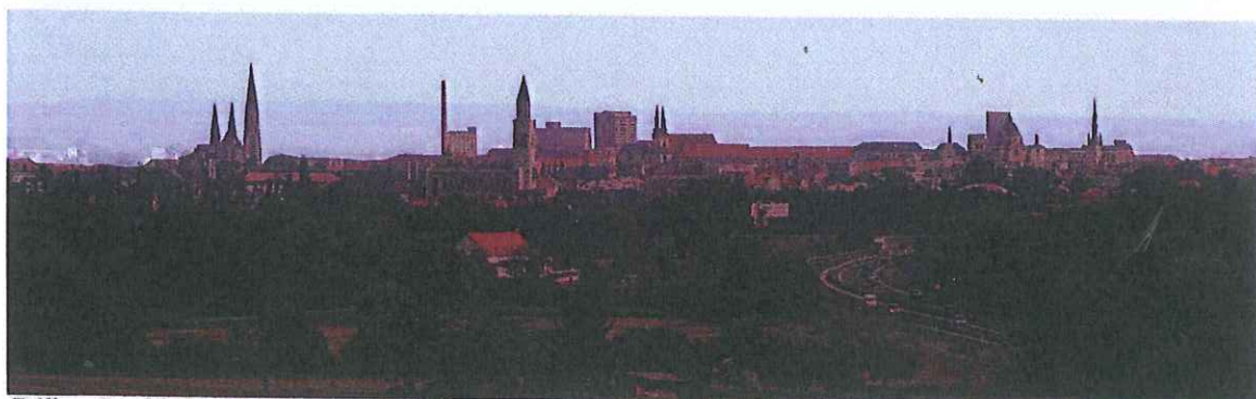
Dálkový pohled od Křelova se zvýrazněnou možnou budoucí siluetou narušenou navrženou výškovou stavbou v areálu kasáren 9.května
