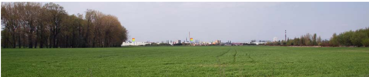
Obr. 48 PS-03: pohled na historické jádro z Holického lesa (nedaleko bývalého Fortu č. VIII) v k.ú. Holice – návrh
