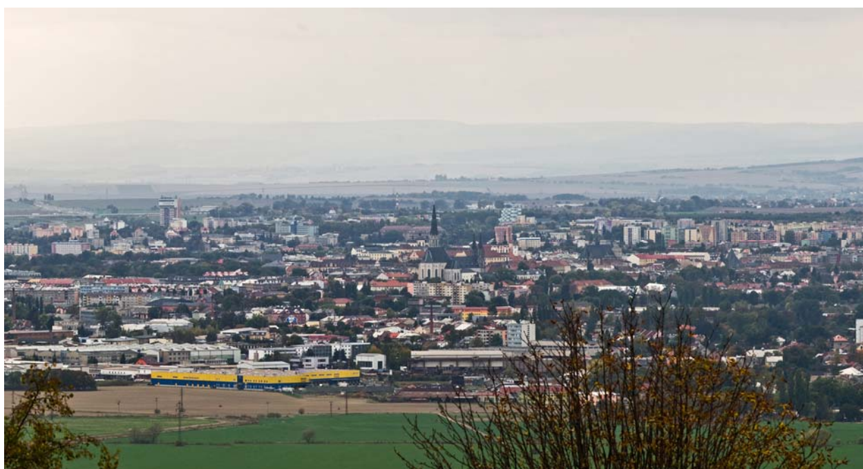
Obr. 70 PS-10: pohled na historické jádro od baziliky Panny Marie svatokopecké – stav výřez
