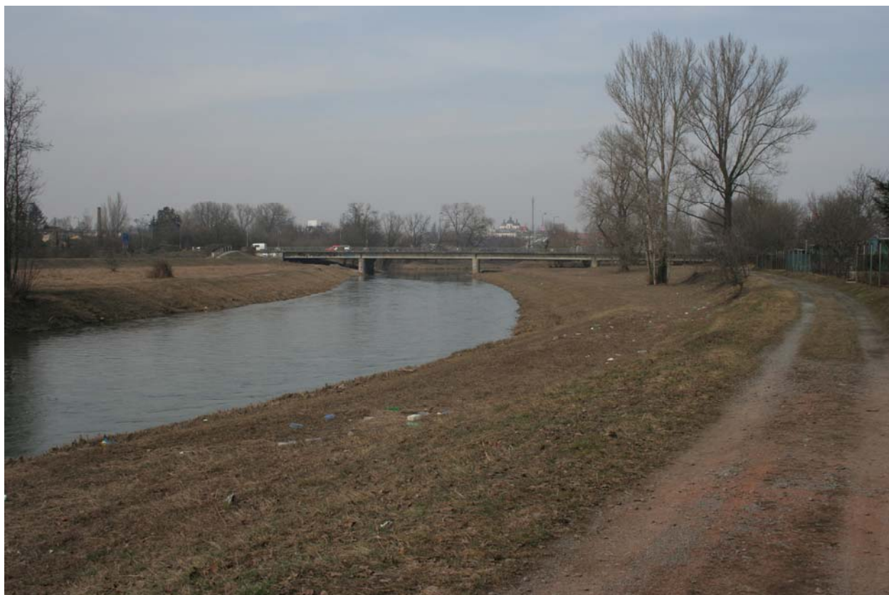
Obr. 82 Pohled z ulice U rybářských stavů směrem k historickému jádru – stav
