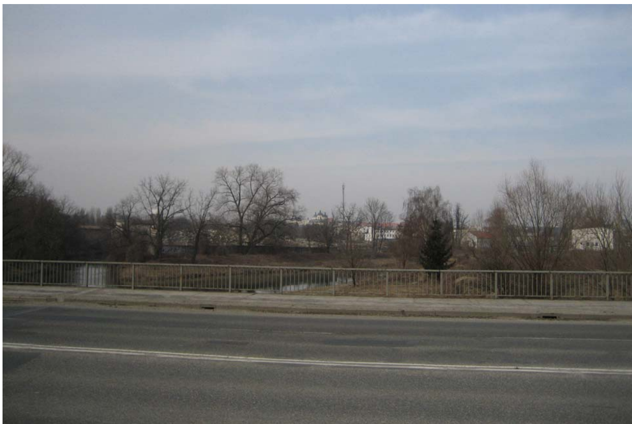
Obr. 84 Pohled z mostu na Velkomoravské směrem k historickému jádru – stav
