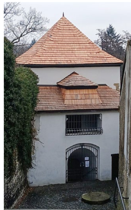
Věž Michalského schodiště (po rekonstrukci).
