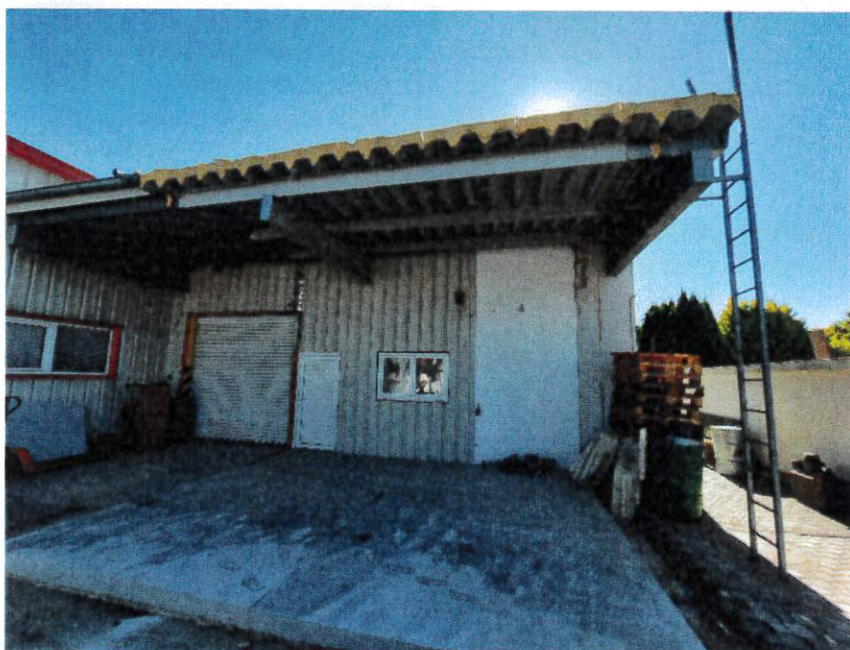
Přístavba skladu parc. č. st. – odstranění
