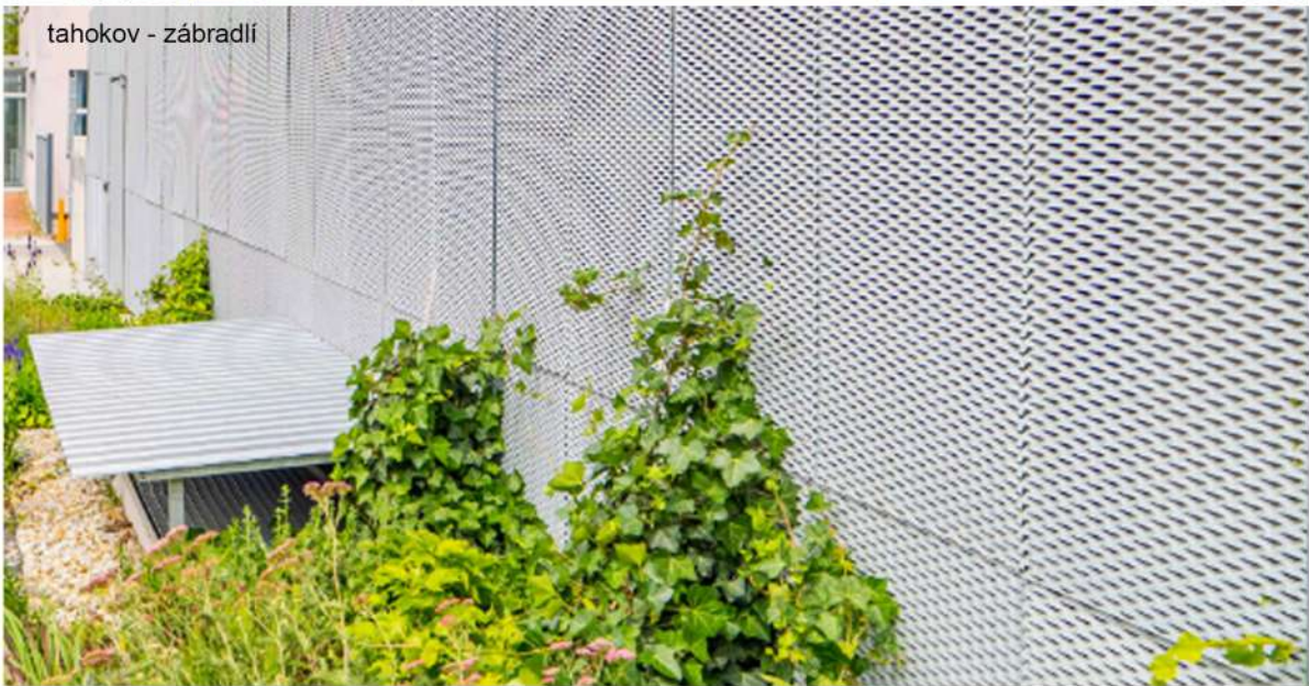
copílit se zapečenou barvou, redukovaná průsvitnost 20%- reference Mlynica Bratislava
