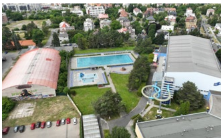
Stará budova malé hokejové haly vedle plaveckého stadionu je určena k demolicí.
