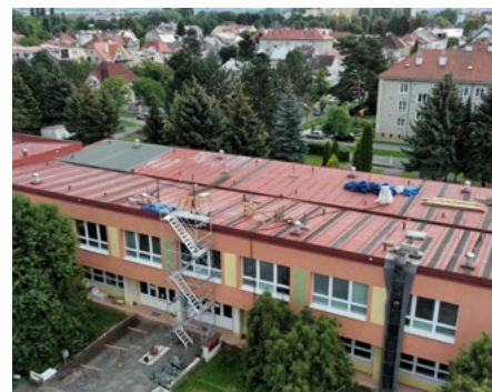
Velká rekonstrukce ZŠ Demlova bude brzy hotová.
