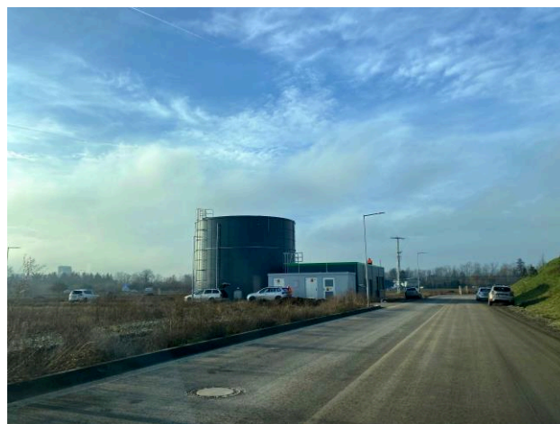
Obr. 11 Vjezd do nové průmyslové zóny podél silnice I/35.
