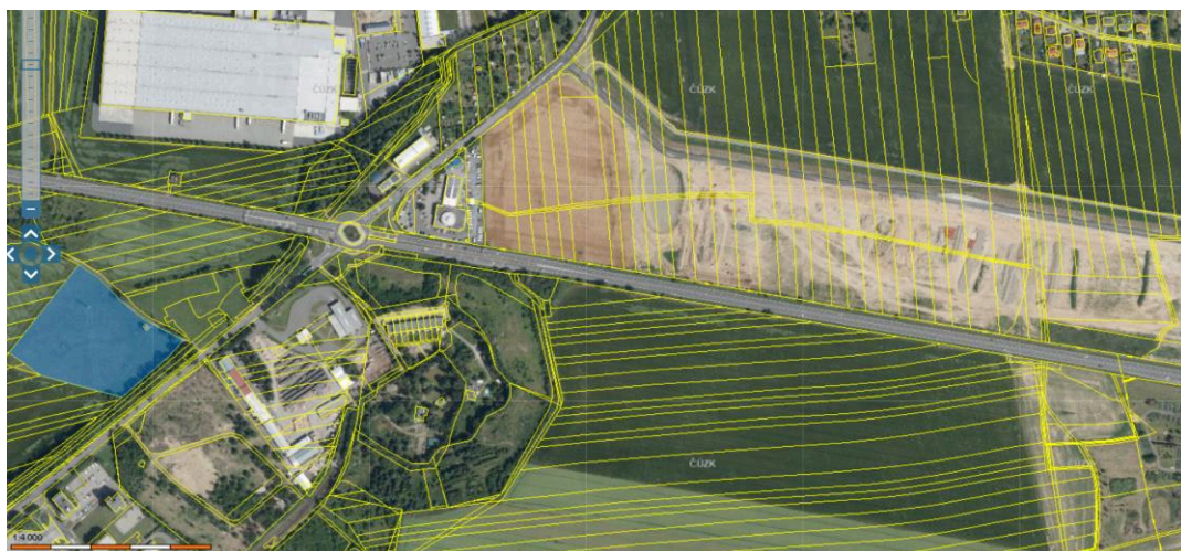
Obr. 13 Výřez leteckého snímku (© www.cuzk.cz) nalétaného dne 19. června 2022, OPVZ OLMA I. stupně je vyznačeno modře. Na snímku je patrná skrývka ornice před zahájením výstavby průmyslové zóny podél silnice I/35.
