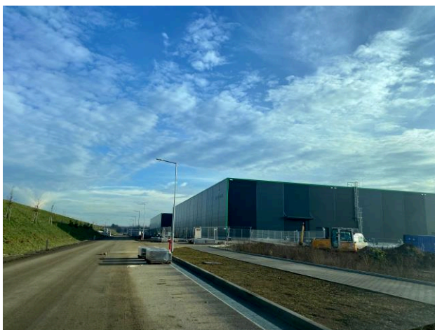
Obr. 10 Nová průmyslová zóna podél silnice I/35.
