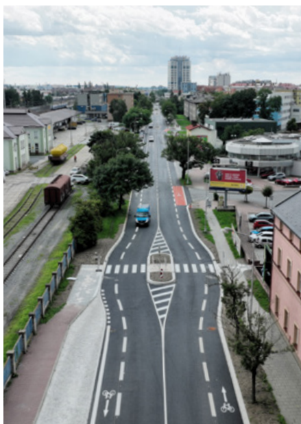
Jeremenkova ulice dostala nový povrch.
