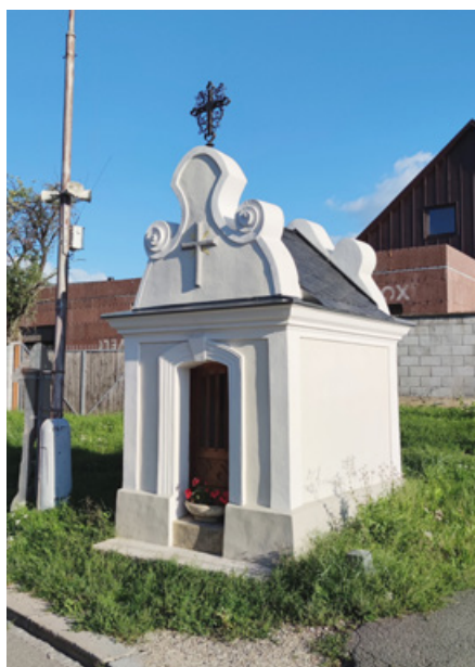
Kaple sv. Isidora má novou střechu i fasádu.
