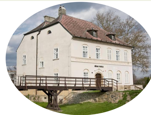
Statické zajištění, rekonstrukce střechy a výměna krovu měšťanského domu č.p. 480
