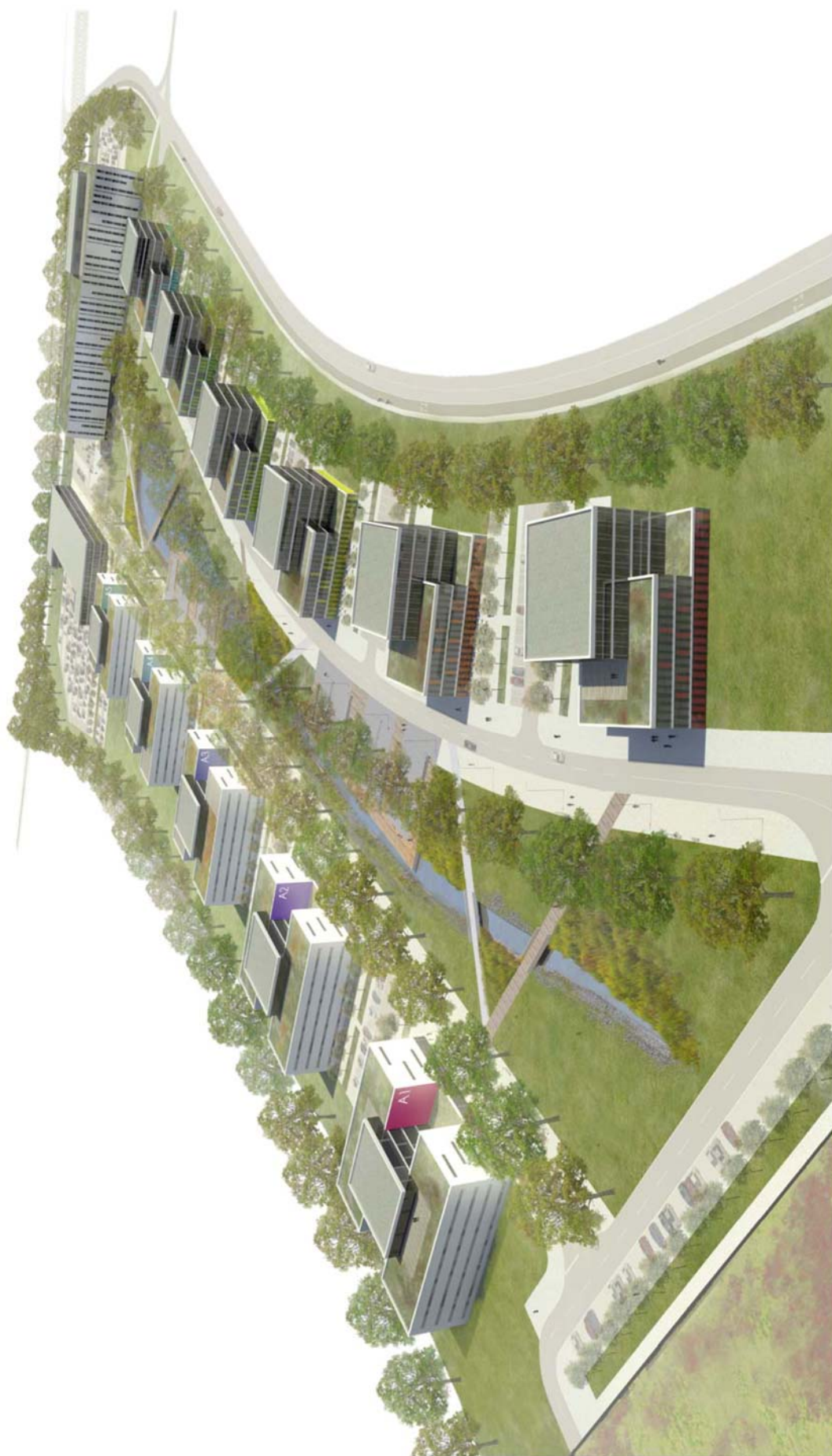
LETECKÝ POHLED NA VÝCHODNÍ ČÁST AREÁLU
