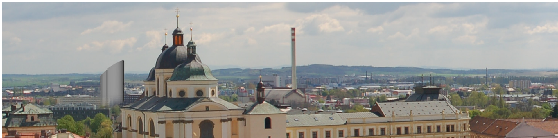
Obr. D13: Pohled MP-11, současný stav – detail
