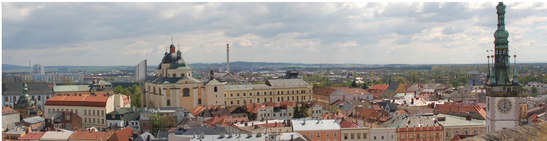
Obr. D12: Pohled MP-11, současný stav
