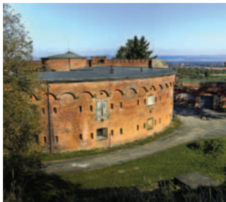
Pevnostní objekty byly sice účelové stavby, je na ně ale i hezká podívaná. Foto MMOI
