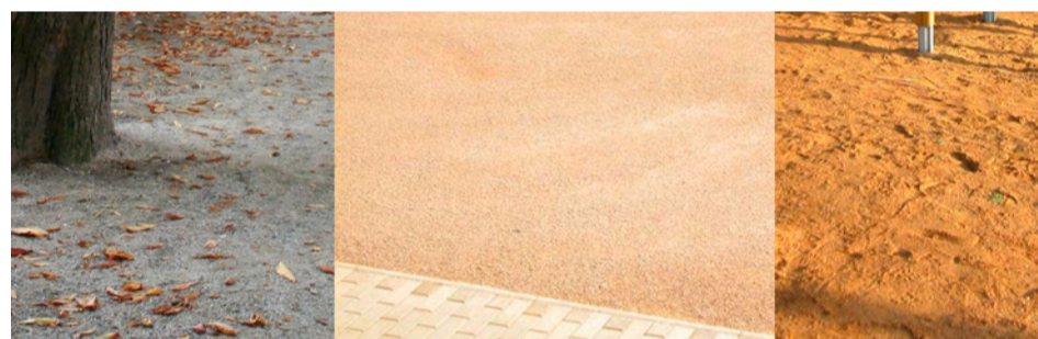
Obr. 12 Detail nezpevněného povrchu – minerální beton (1,2) a pískový mlát (3)
