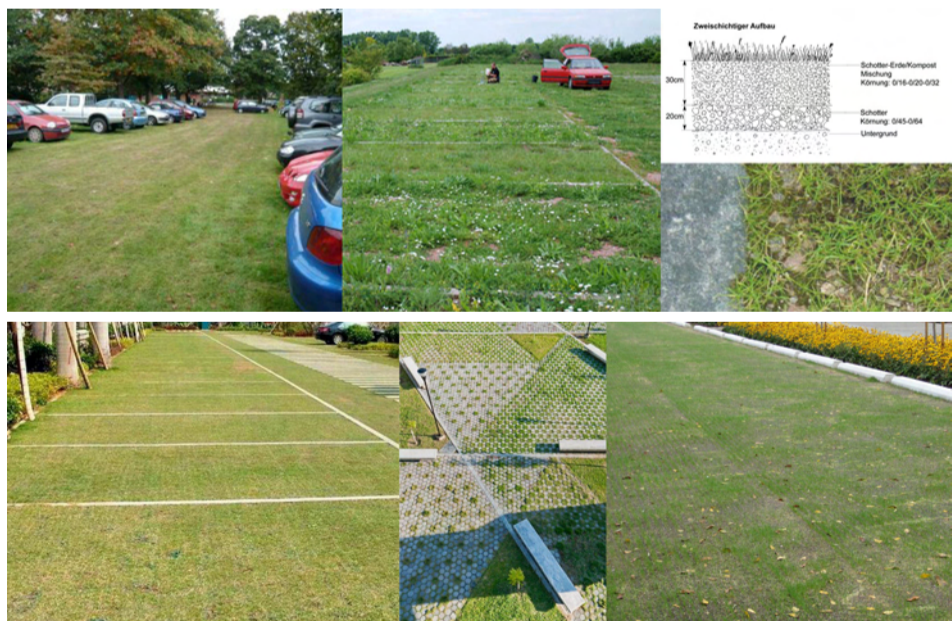
Obr. 10 Příklad zatrávněných ploch pro parkování – štěrkový trávník (nahore), zatrávňovací dlažba/rohože (dole)
