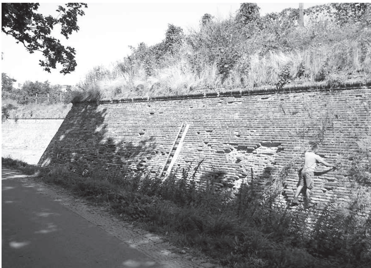
Korunní pevnůstka vyžaduje nejen rekonstrukci, ale i průběžnou, nikdy nekončící péči, jako je například čištění hradeb. Foto: Michal Folta
