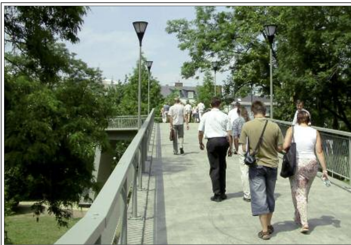
Návštěvníci olomouckého výstaviště Flora budou moci po téměř patnáctileté přestávce opět využívat nově zrekonstruovanou unikátní nadzemní lávku.
