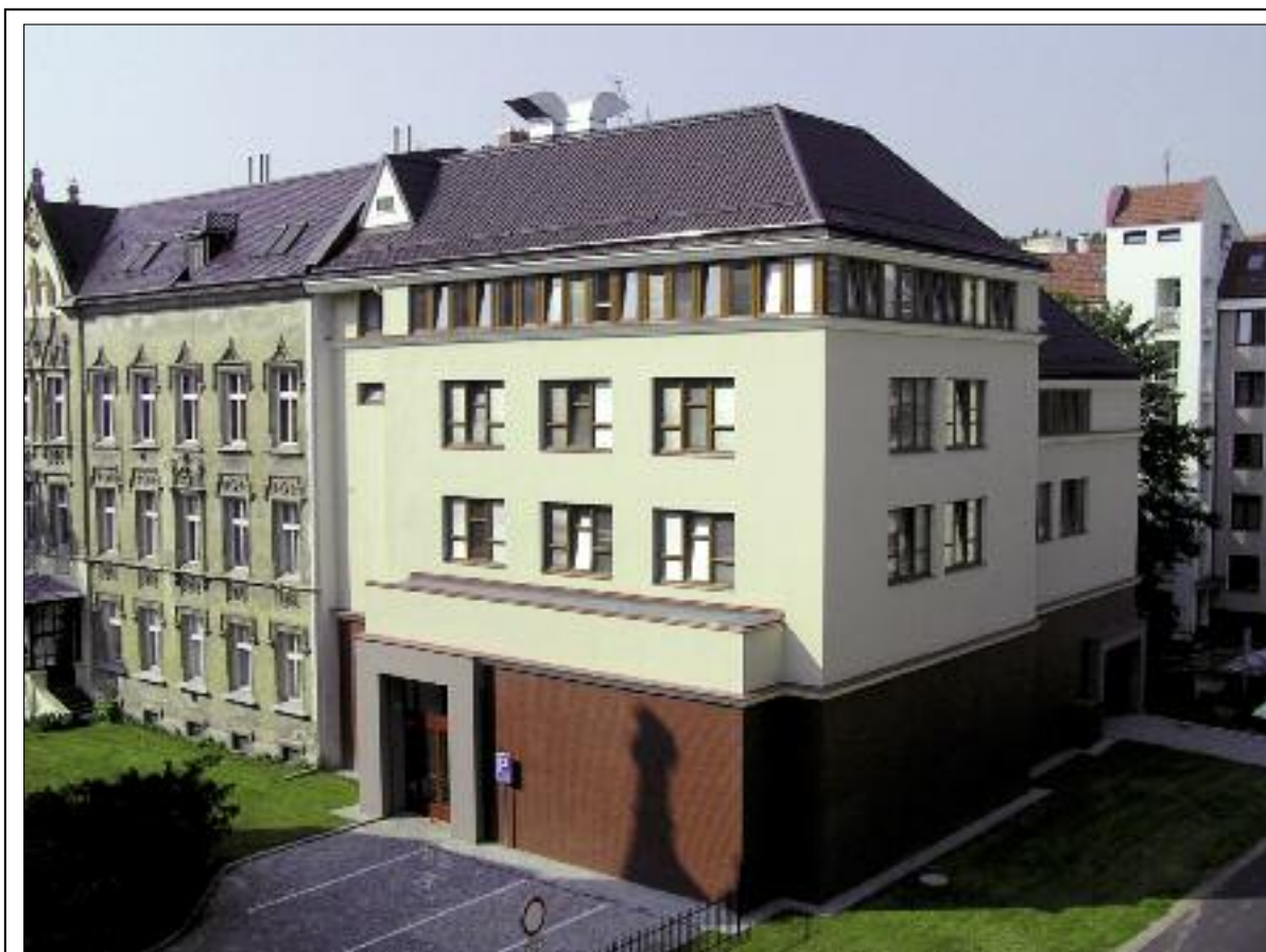
Vědecká knihovna v Olomouci / dostavba a rekonstrukce skladu knih v Ulici Bezručově
