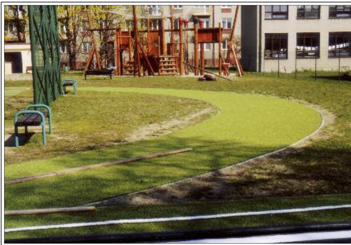
ZŠ Tererovo náměstí - školní hřiště a dostavba
