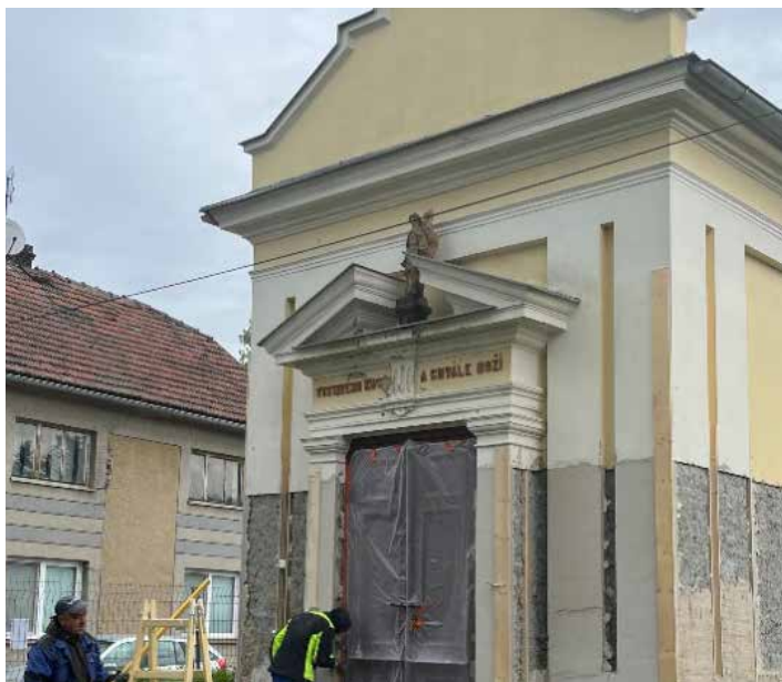
Kaplička během rekonstrukce
