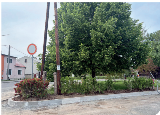
Výměna obrubníků na točně autobusové zastávky
