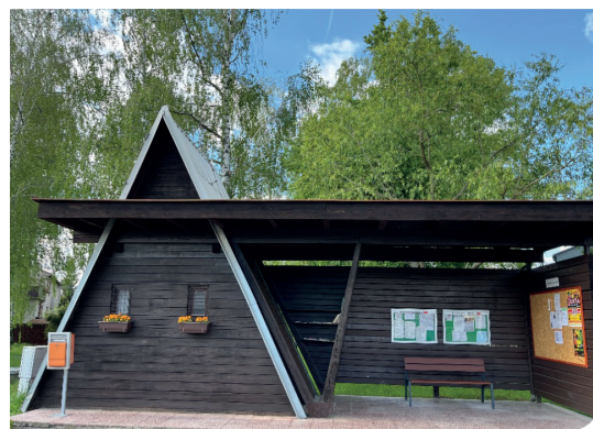
Rekonstrukce autobusové zastávky včetně vybudování mobilní knihovny a veřejné nástěnky
