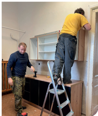
Vybudování nové kuchyňské linky v předsádku tělocvičny MŠ Týneček
