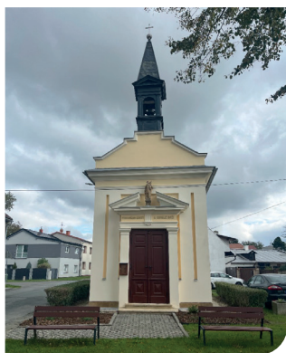
Rekonstrukce a oprava kapličky v Týnečku
