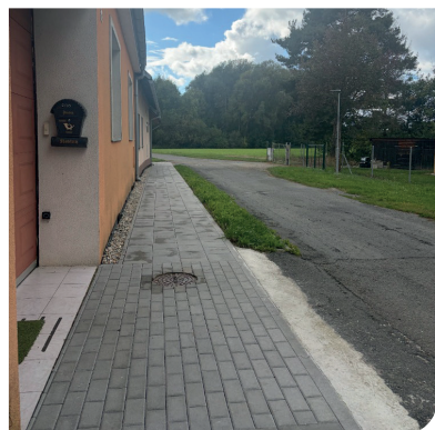
Rekonstrukce chodníku na ulici Chaloupky
