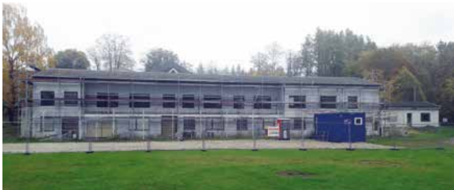
Foto: Budova Křičkova 4 – zahájení rekonstrukce říjen 2024, Autor: F. Prášil
