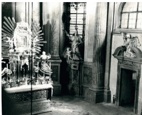
P. G. Riedl se zasloužil o obnovení interiéru baziliky, archiv J. Gottwalda.
