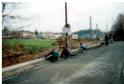
Stavba chodníku k ZOO
