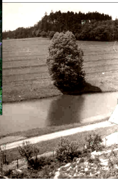
Dole: fotografie vodárenské nádrže z roku 1973-74
