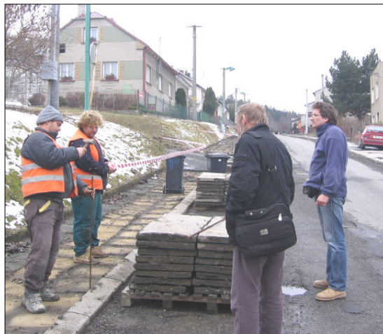
Stavba začala rozebíráním dlažby.....,
