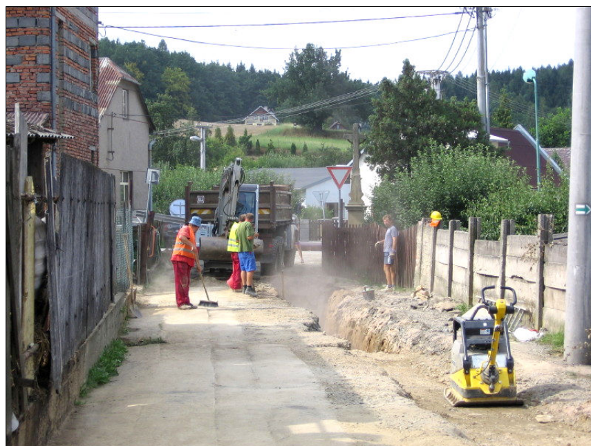
Práce na ulici Lošovská
