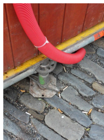
porušení podmínek památkové ochrany- chybějící podkladky pod stojkami pódia
