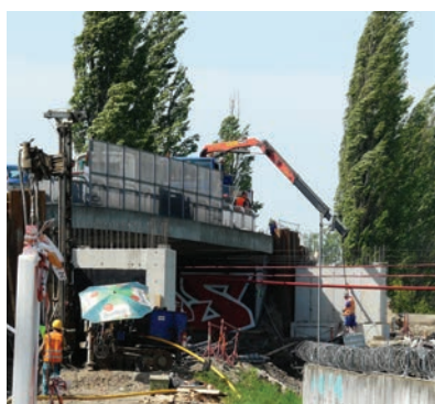
Snímek z května zachycuje práce na lávce přes železniční trať.
