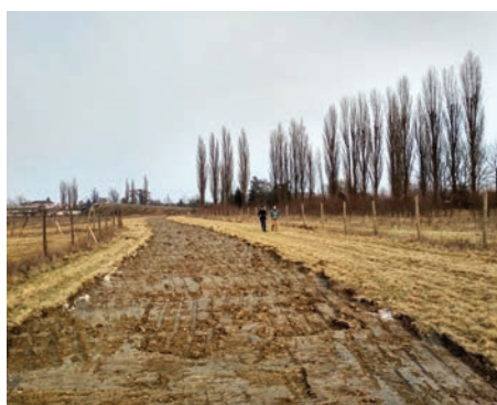
Práce byly započaty v březnu, tento snímek zachycuje stav v dubnu.
