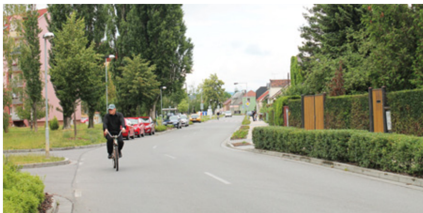
Přichystalova ulice – nová silnice, chodníky, základy pro parkování a hlavně zeleň.
