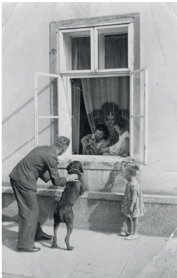
▲ U okna již neexistující budovy staré školy, 1938
