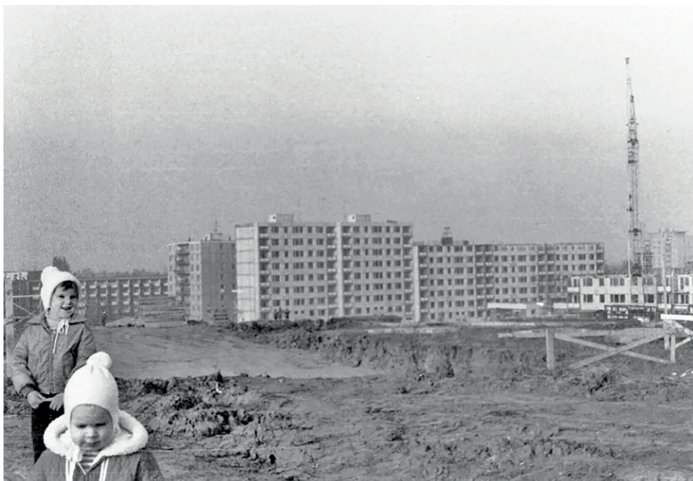
▲ Neředínská „panelstory“. Pohled na vznikající blok ulice Stiborova v roce 1986
