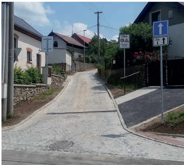
Ulice Zlaté doly po rekonstrukci
