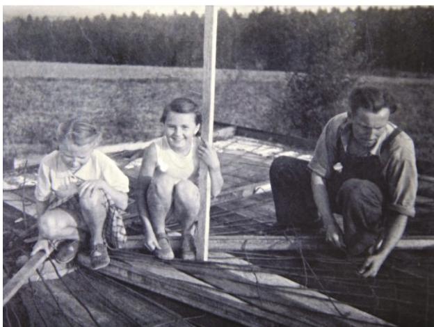
základová deska hvězdárny...
