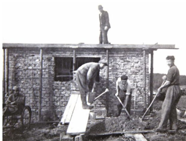
první úspěch, přízemí je hotovo...
