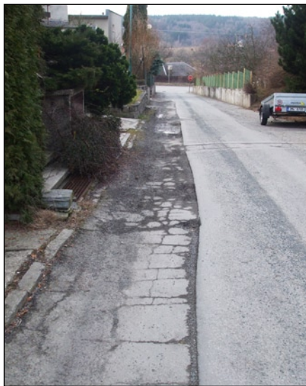
pohled na ulici Pod Lesem před opravou
