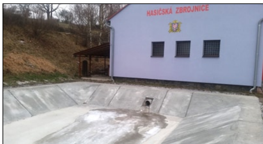
hasičská nádrž po opravě
