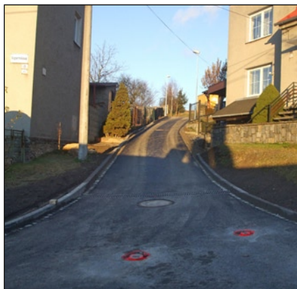
a po opravě
