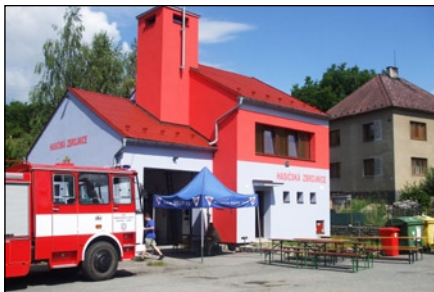
opravená zbrojnice při dnu otevřených dveří
