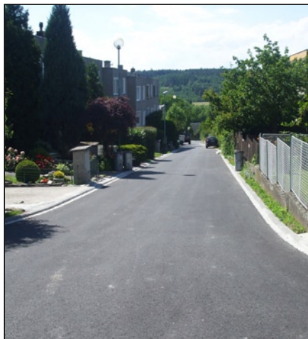
a po opravě
