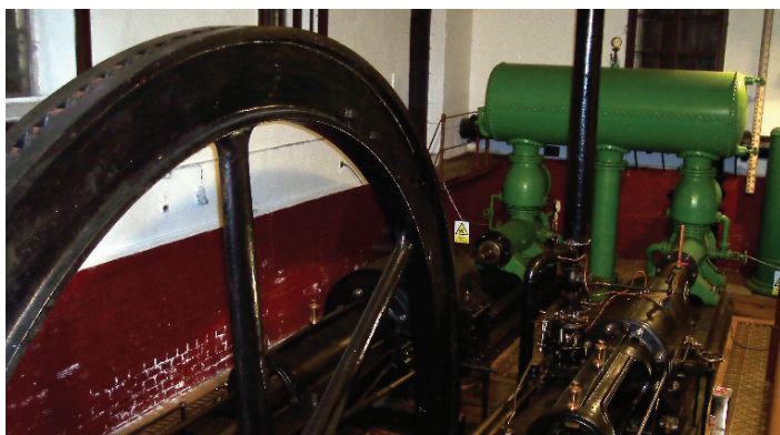
Setrvačnicková kola se natrvalo zastavila až v květnu 1960, kdy byla parní vodárna vyřazena z provozu. Foto: archiv společnosti Moravská vodárenská, a. s.
