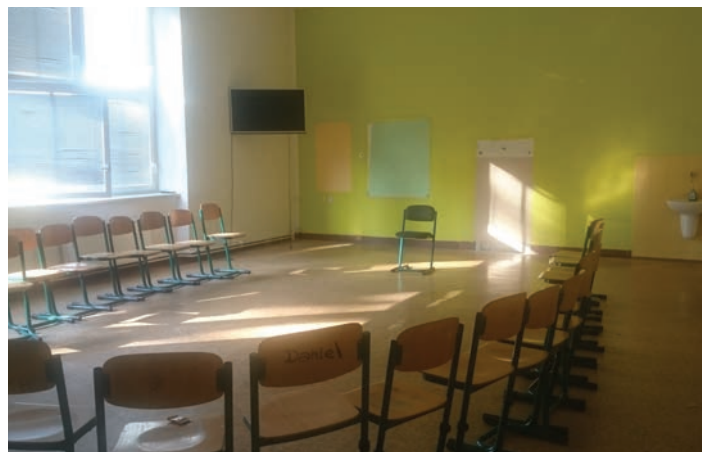
Na konci června už byly třídy připraveny k rekonstrukci, foto: Zuzana Pustinová
