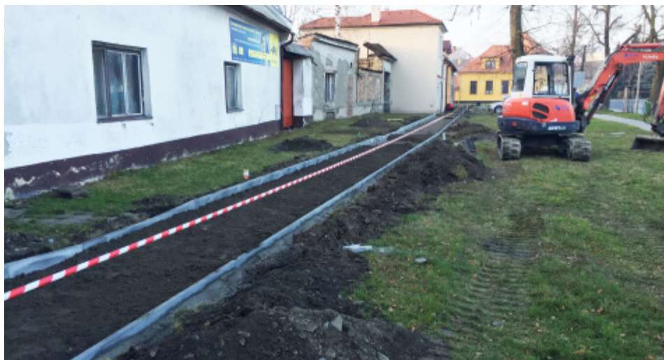
Pokládka nového dláždění chodníku na Selském náměstí. Foto: Bohumil Šíp
