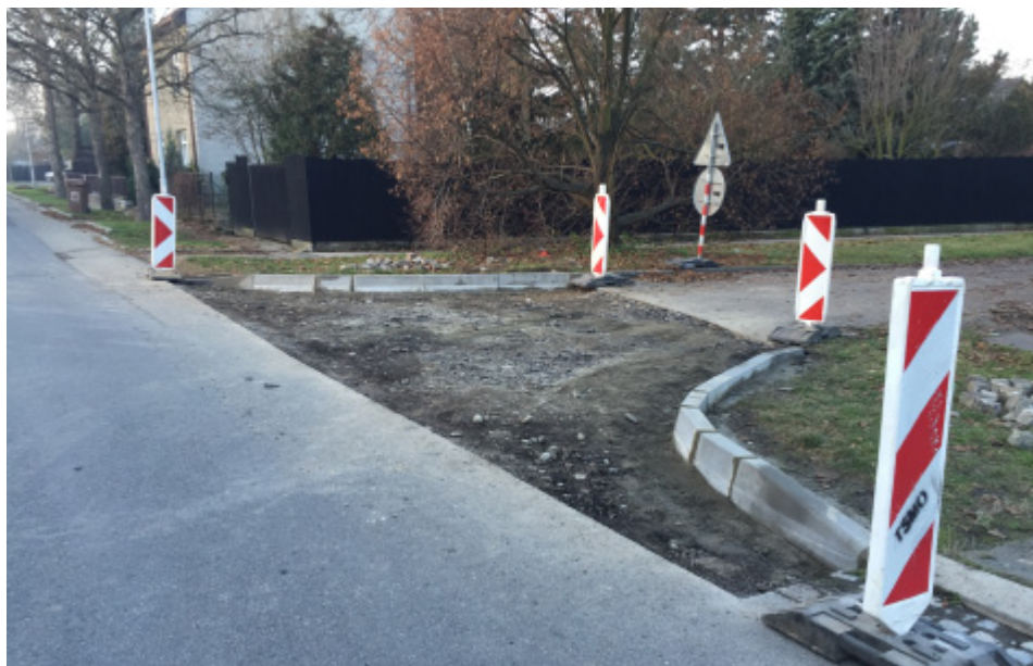
Oprava části silnice v ulici Na Zákopě. Foto: Bohumil Šíp
