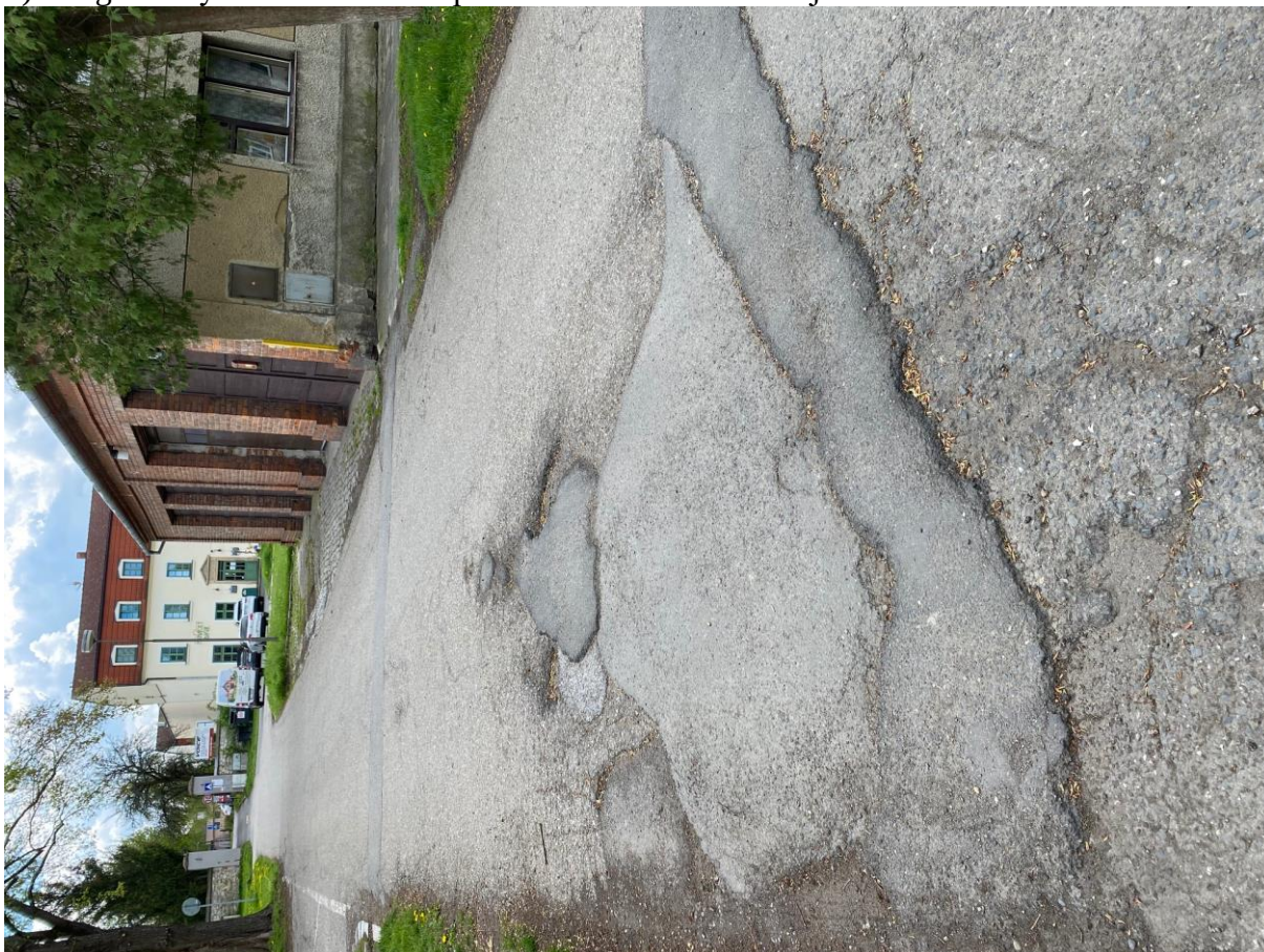
2) fotografie výtluků ve vozovce před starou hasičskou zbrojnicí
