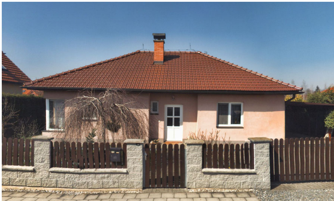
obr.: objekt typu „bungalov“ (např. Majetín, č.p. 366)
