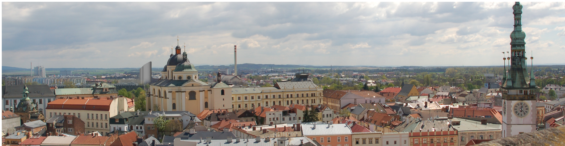
Obr. D12: Pohled MP-11, současný stav
