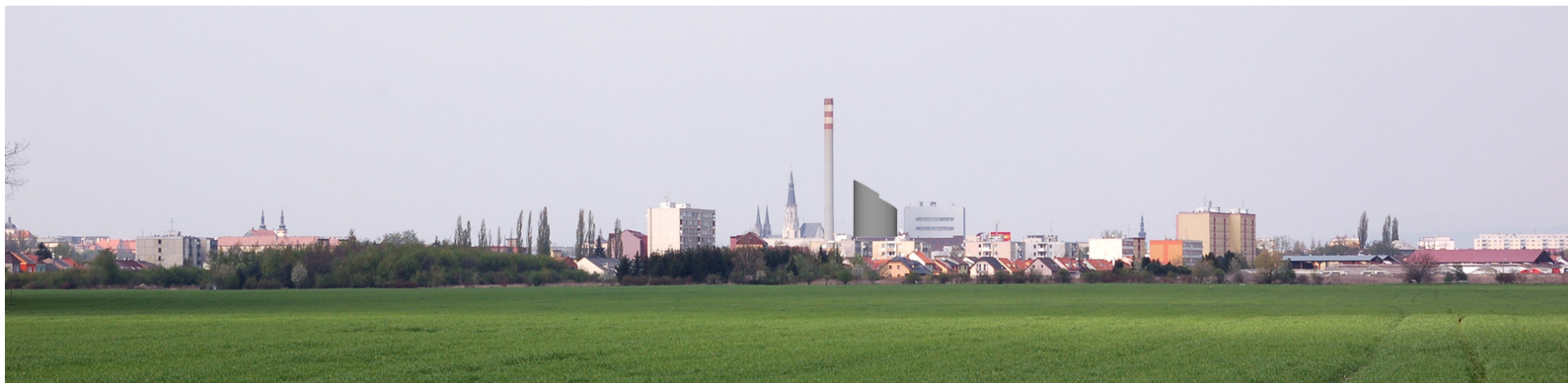
Obr. D05: Pohled MP-03, současný stav – detail
