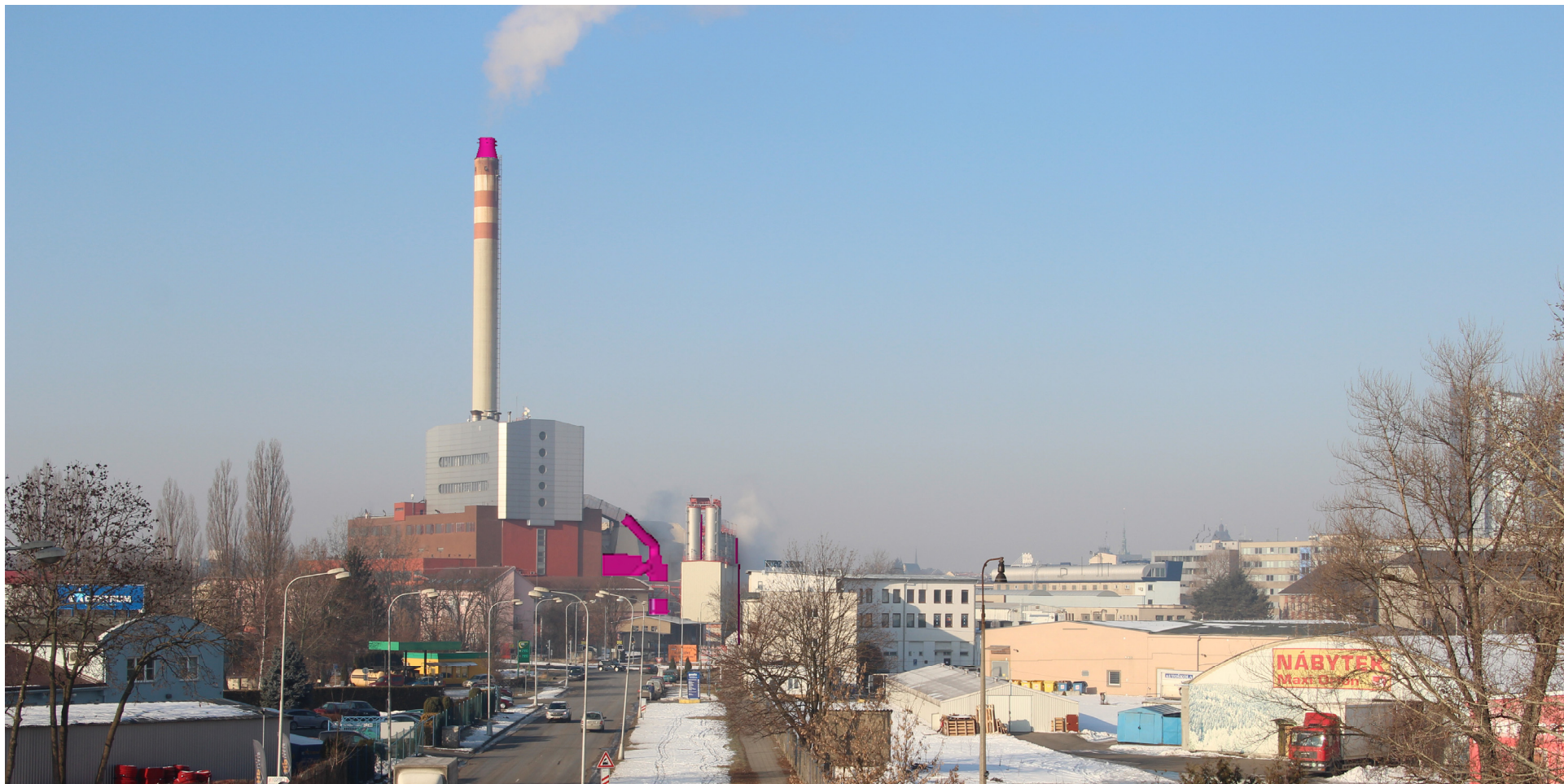
Obr. D21: Pohled z Velkomoravské ulice, varianta A (patrný je konfusor na komíně a rekonstruovaný filtr)
