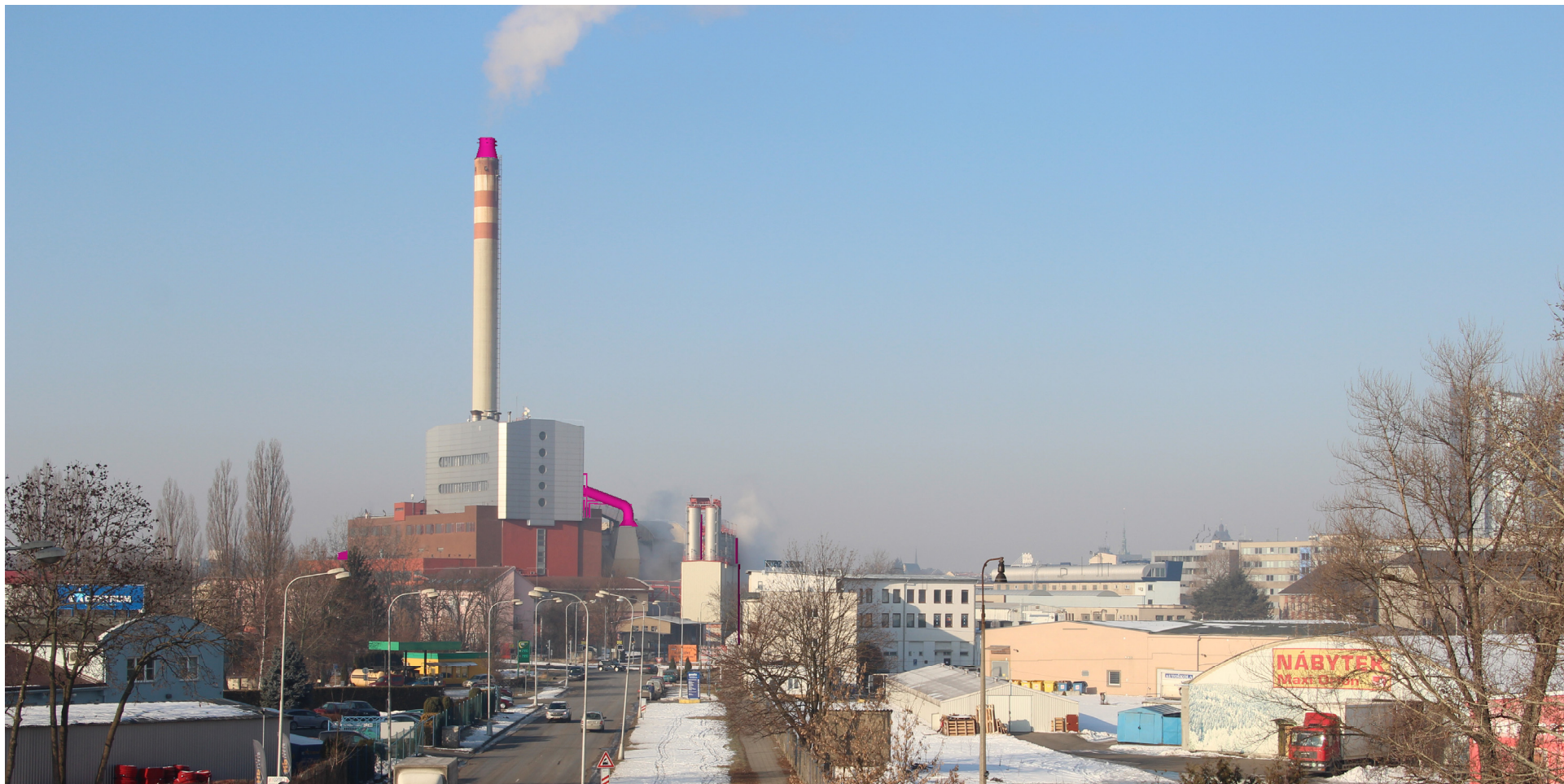
Obr. D23: Pohled z Velkomoravské ulice, varianta C (patrný je konfuzor na komíně, nové kouřovody a vlevo malá část nového filtru)
