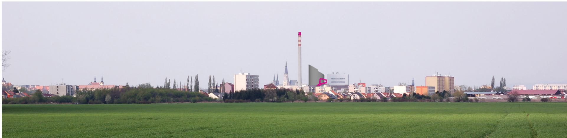
Obr. D09: Pohled MP-03, varianta B – detail (patrný je konfusor na komíně a nové kouřovody)
