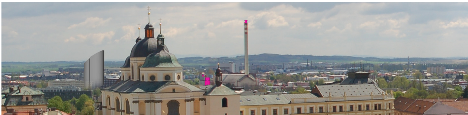
Obr. D15: Pohled MP-11, varianta A – detail (patrný je konfuzor na komině a nové silo aditiva)
