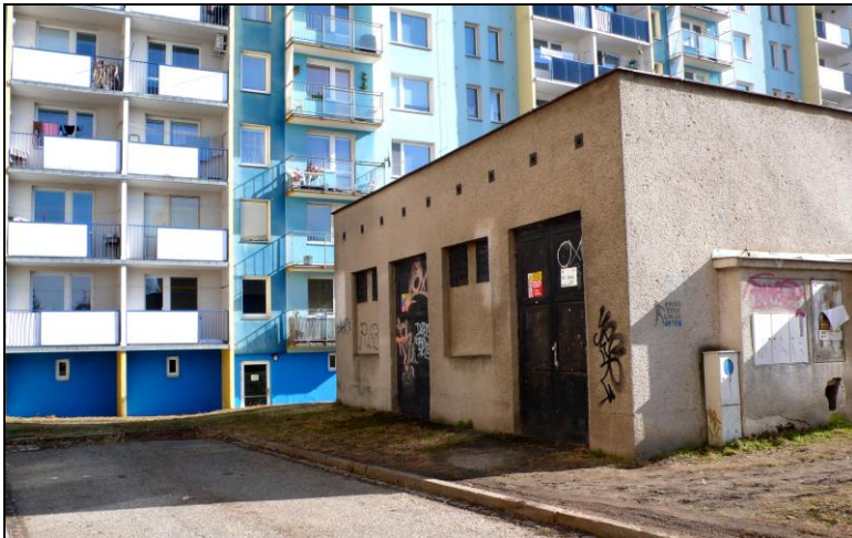
Trafostanice ve vnitrobloku ulice Kischovy (DTS 3865 Povel, Schweitzerova)
