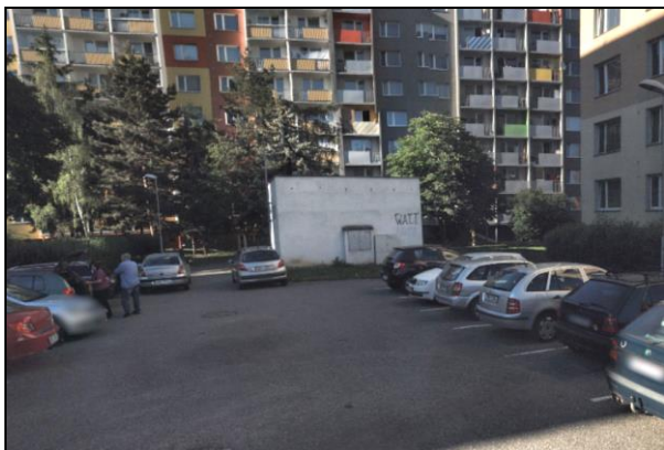
Stávající betonová trafostanice V Křovinách
