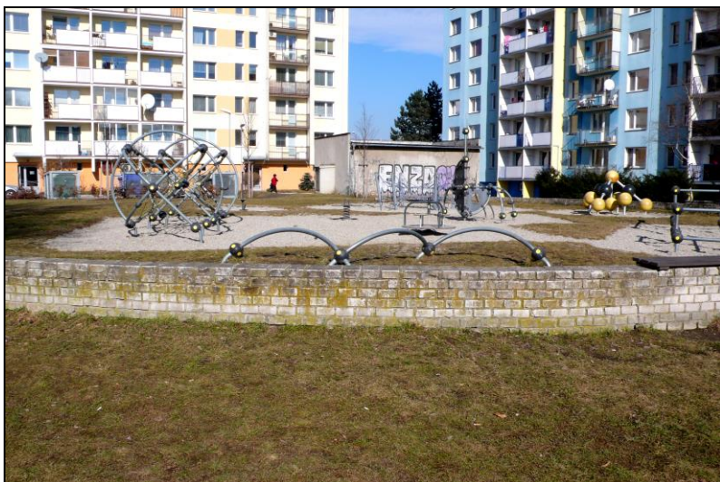
Dětské hřiště Nedvědova, v pozadí trafostanice
