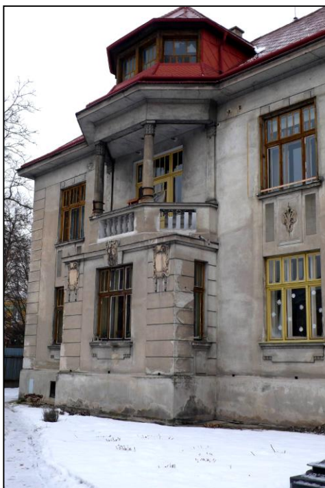
Vila na ulici Dvořákové č. 266/36
