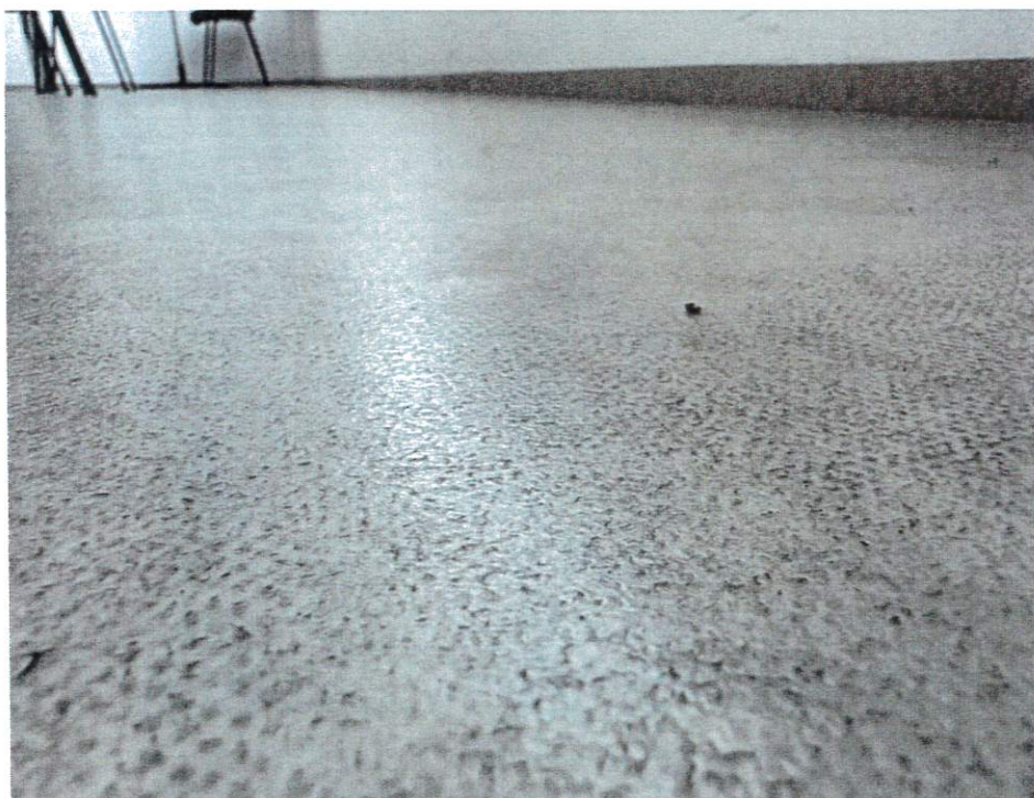
Odolná protiskluzná podlahová krytina na většině podlah v interiéru stavby – špatně čistitelná
