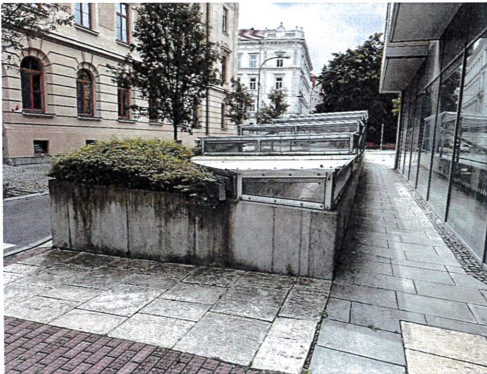
Sjezd do podzemních garáží zakrytý ocelovou konstrukcí s polykarbonátem
