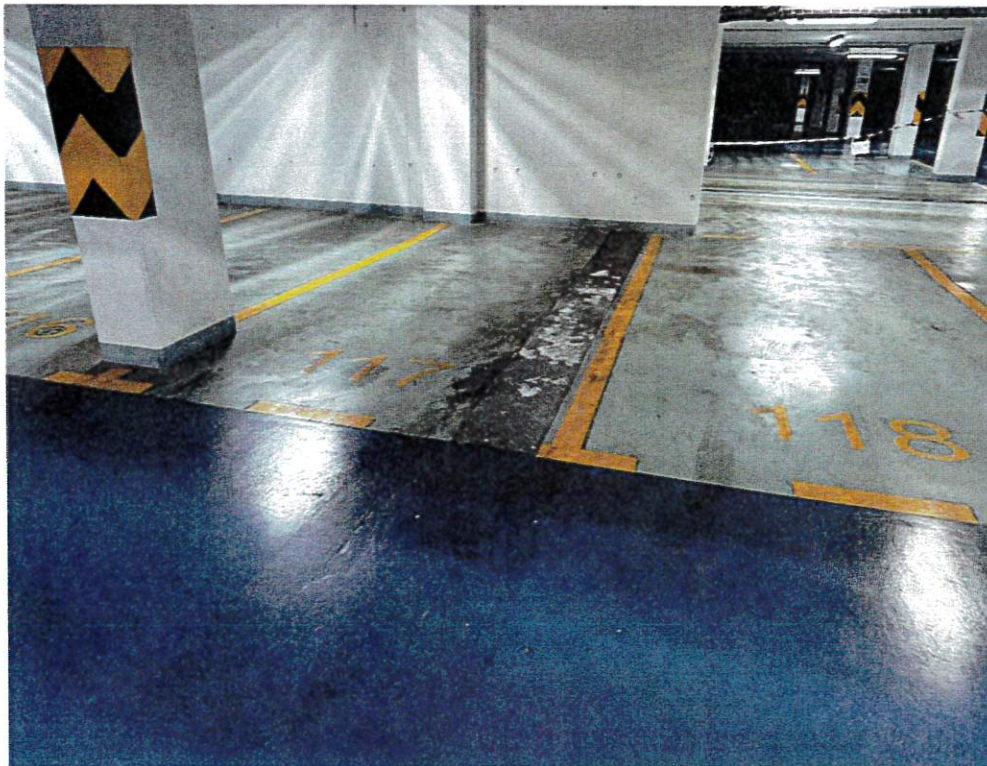
Částečné překrytí obnažené dilatační spáry plechem v podlaze garáží ve 2.PP
