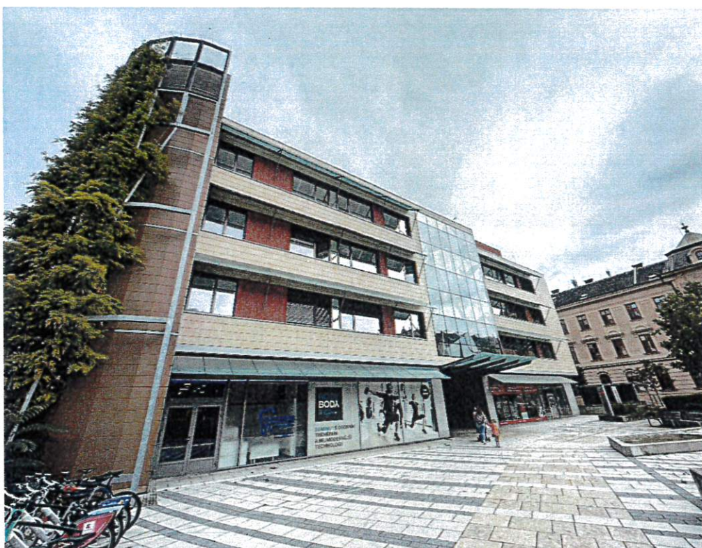
Prosklená plocha rizalitu nad hlavním vstupem s kancelářemi za skleněnou plochou jižní fasády
