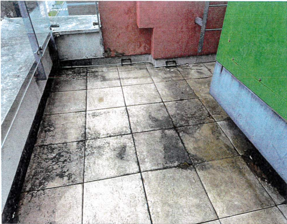
Detail terasy v 5.NP s protiskluznou betonovou dlažbou
