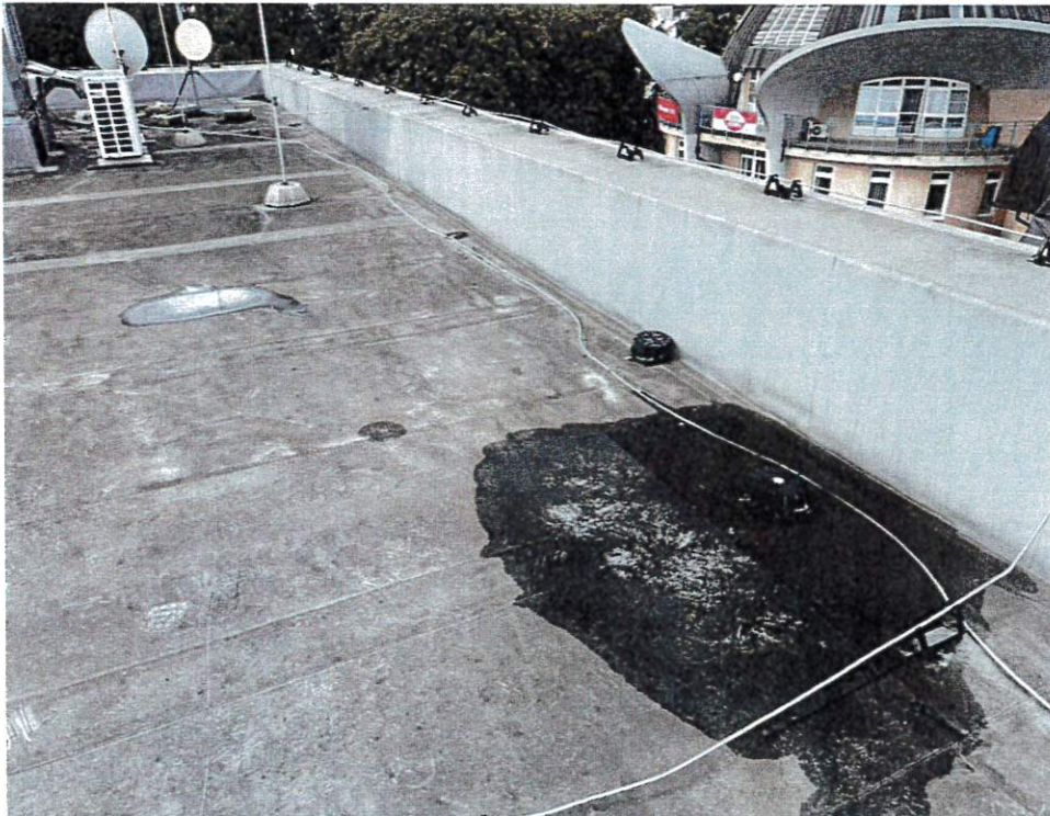
Střešní krytina po výměně kol. r. 2020
